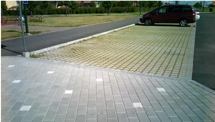
Kuva 15. Lämpäsevän päällysteen käyttö pysäköintialueella (Kartanokosken liikuntapuisto).
