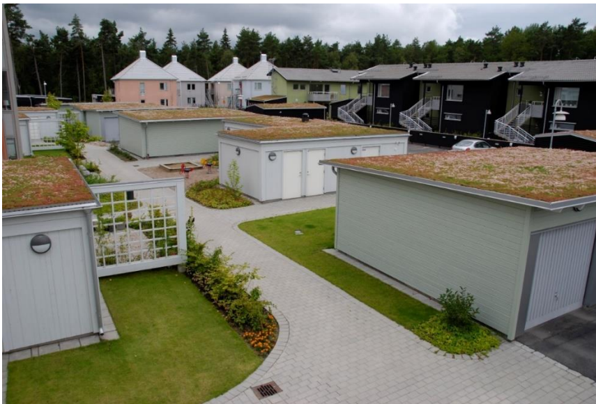
Kuva 14. Viherkatot varastorakennuksissa ja autotalleissa.
