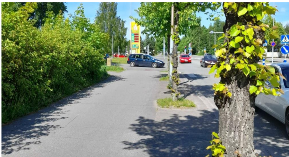
Kuva 1. On tavattoman yleistä, että Kivistön kaupan pihasta poistumaan pyrkivät autoilijat (kuvassa tummansininen farmariauto) pysähtyvät liittymässä siten, että he väistämiselvollisuudestaan huolimatta estävät pyöräilijöiden ja jalankulkijoiden kulun yhdistetyllä pyörätiellä ja jalkakäytävällä. Kuvan tilanne on kuvattu Ruukintien puolelta.
