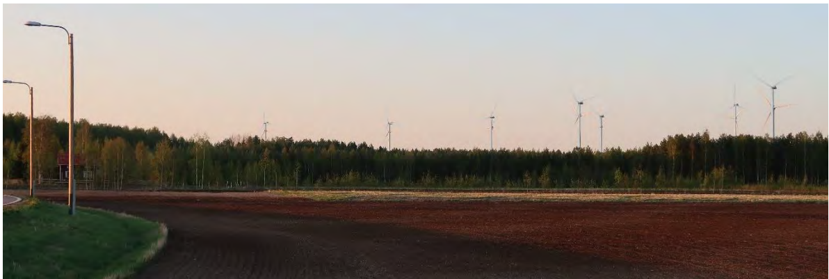
Kuva 66. Vertailukuva Isovuoren hankkeen voimaloiden koosta (270 m) suhteessa kuvassa näkyviin Lapuan Jouttikallion olemassa oleviin voimaloihin (210 m). Isovuoren hankkeen voimalat on mallinnettu Jouttikallion voimaloista otetun valokuvan päälle. Kuvaspaikka Jouttikallion voimaloista n. 3–5 km lounaaseen.
