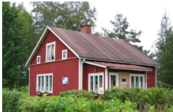
Kuva. Sissalan päivätoimintakeskuksen rakennus, Ojelmistontie 1. Lähde: Kulttuuriympäristösovellus.fi. KIOSKI 3.0.
