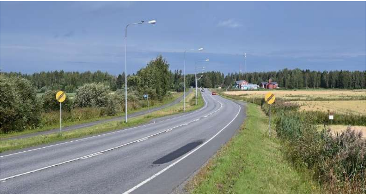
Kuva D. Vt 18 Munakan maantiesillan pohjoispuolella. Tiealuetta ympäröivä Jokikorven peltolakeus on osa valtakunnallisesti arvokasta Kyrönjoen maisema-alueita. Peltoalue toimii myös Etelä-Pohjanmaan kautta tapahtuvan harmaahanhimuuton muuttokäytävänä. Pelloilla levähtää erityisesti keväisin tuhansia metsä-, tundra- ja lyhytnokkahanhia. Syksyllä Jokikorven pellot keräävät syysmuutolle valmistautuvia kurkia. Tieluiskien kasvillisuus koostuu tyypillisistä rehevien niittyjen lajeista. Kuvaussuunta NW.
