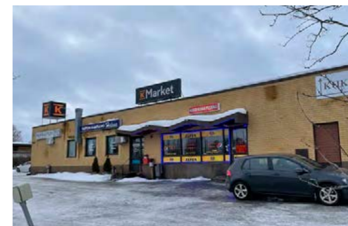
Neuvolan väistötilat Terveyskeskuksen ja palvelutalon välissä.
