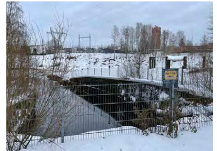
Patoaltaan ja kanavan betoniseinäisen purkualue jokirannassa.
