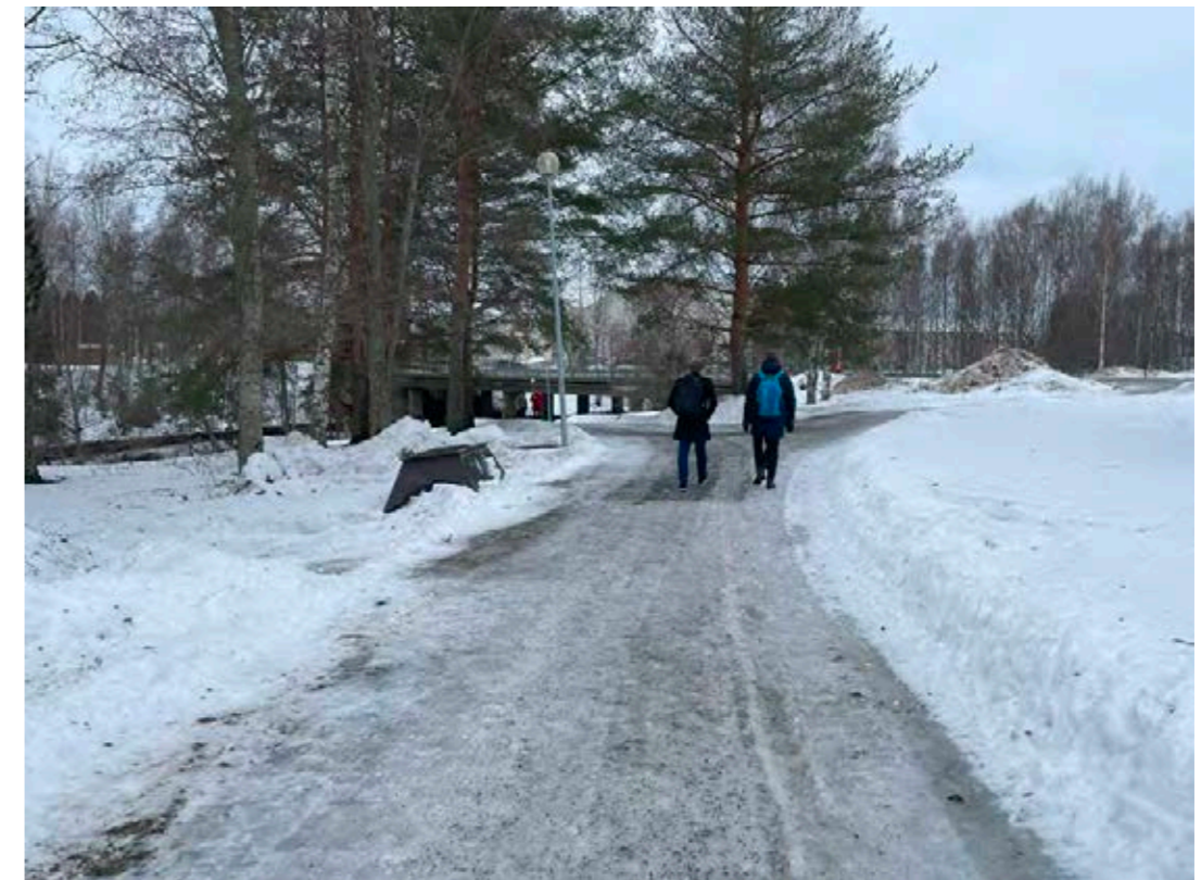
Kirkkokadun silta Friskinlammin yli.
