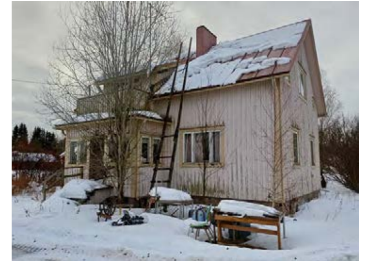
Pohjoisin Huhtalantien varren omakotitaloista.
