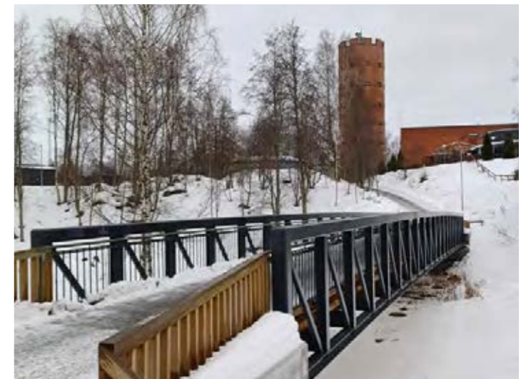
Silta ja vesitorni.
