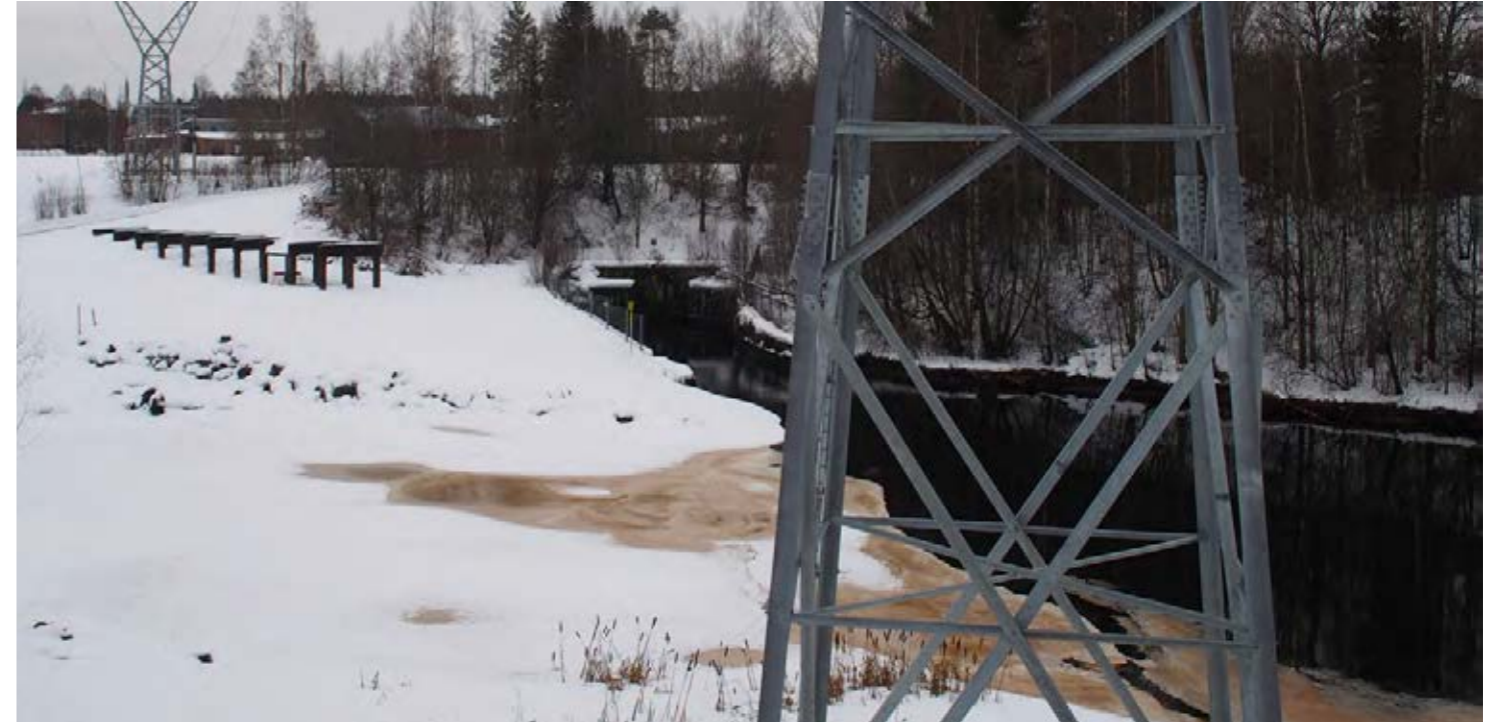
Pohjanlepakot käyttävät saalistusmaastonaan jokiuoman suvantopaikkoja ja Kyrkösjärven purkutunnelin suuaukkoa. Lisääntymis- ja levähdyspaikkoinaan pohjanlepakot käyttävät myös kuvassa näkyviä purkutunnelin rakenteita.
