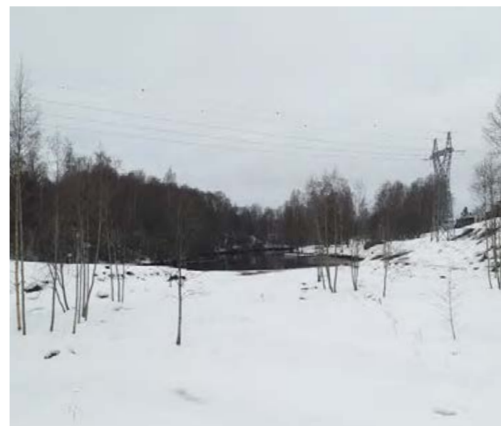
Myllykosken sähköasema ja johdot hallitsevat voimakkaasti joen yli aukeavia näkymiä.
