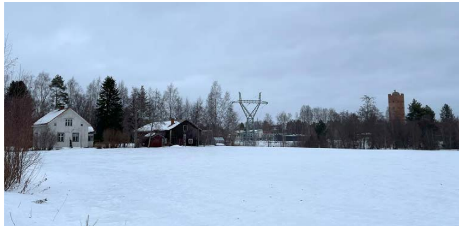
Vanha vesitorni toimii maamerkinä suunnittelualueen eteläosissa. Myllykosken sähköasema ja siihen liittyvät johdot aiheuttavat maisemakuvan laatua heikentävän maisemahäiriön, vaikka sähkövoimaloilla onkin historiaa kyseisessä paikassa.
