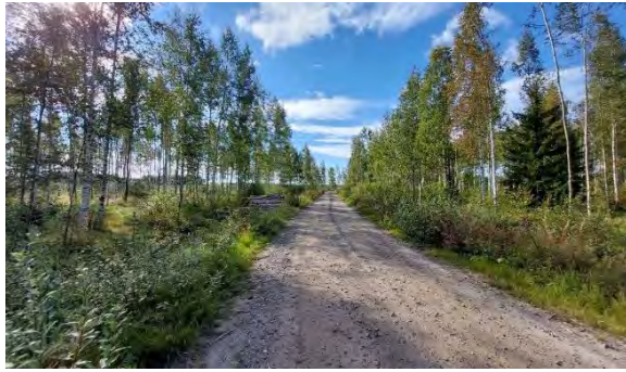
Kuva 26. Tielinja kulkee olemassa olevalla tiellä, jonka molemmin puolin on harvennushakattua koivikkoa.
