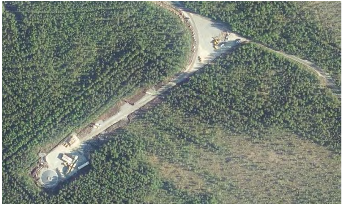
Kuva 9. Esimerkki tuulivoimalan rakennustyömaasta. Ilmakuvan lähde: Maanmittauslaitos, avoimet aineistot 2022
