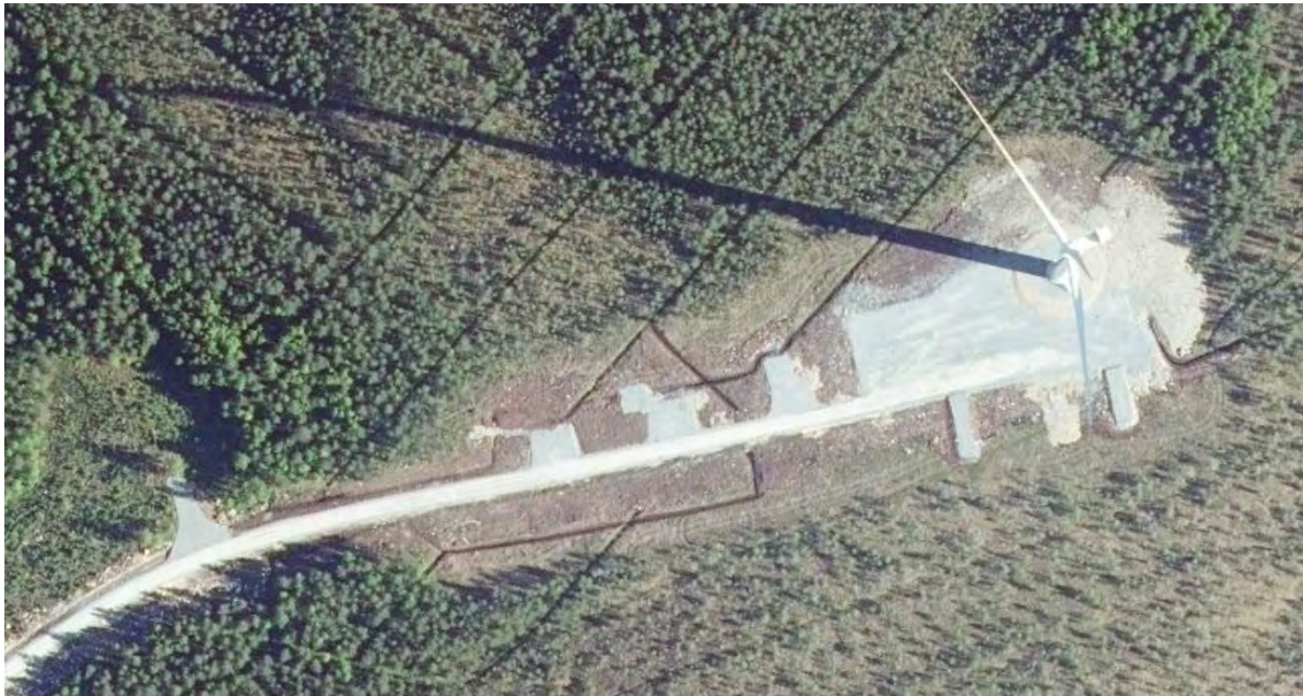
Kuva 10. Esimerkki juuri valmistuneen tuulivoimalan asennusalueesta. Ilmakuvan lähde: Maanmittauslaitos, avoimet aineistot 2022.
